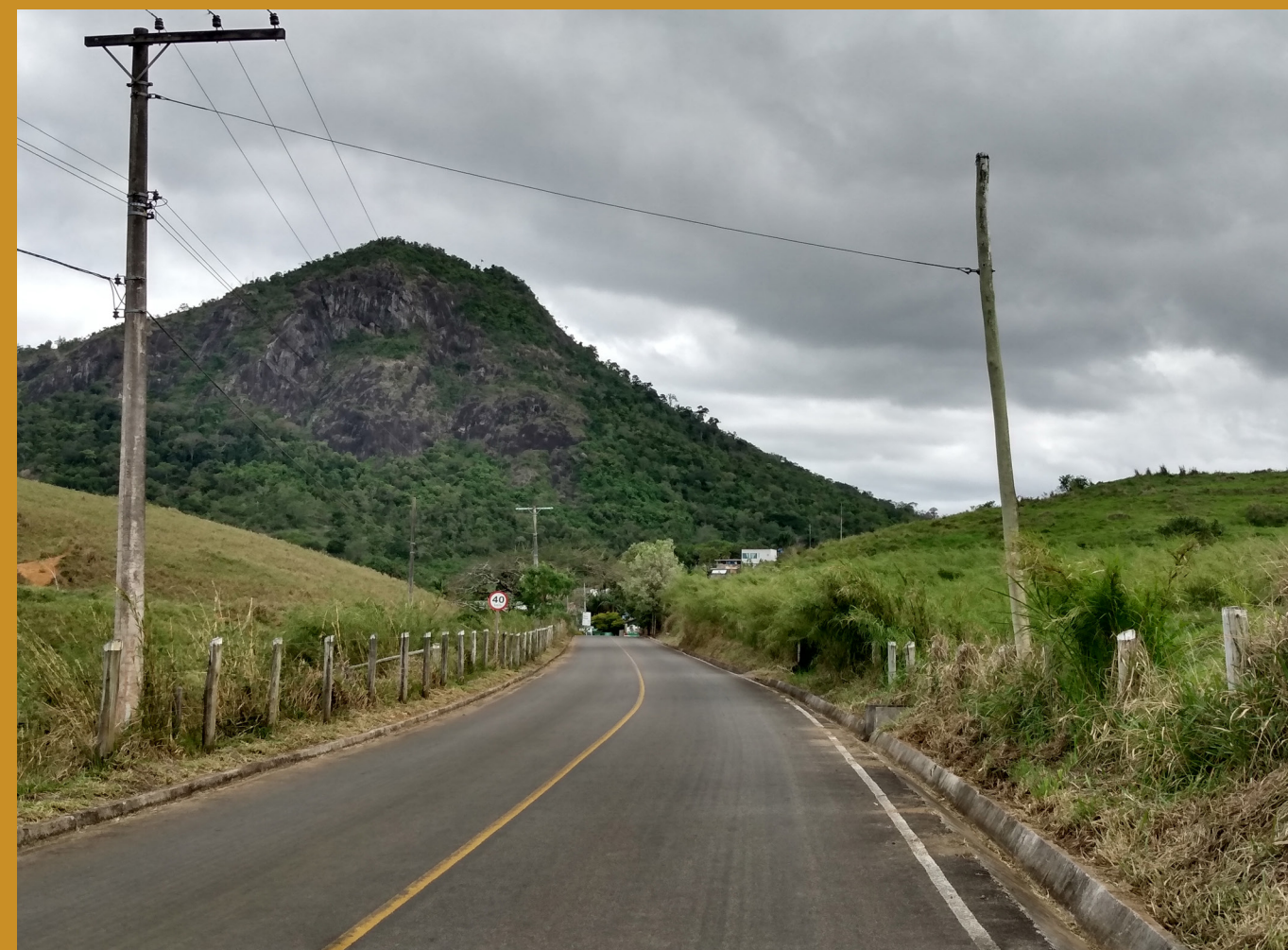
Figura 12: Estrada de acesso ao bairro Araçatiba.
