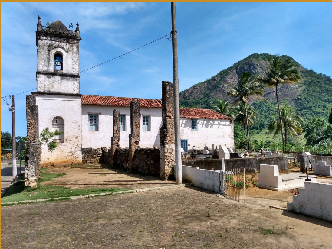
Figura 26: Ruínas da antiga residência jesuítica e o cemitério da antiga fazenda.
