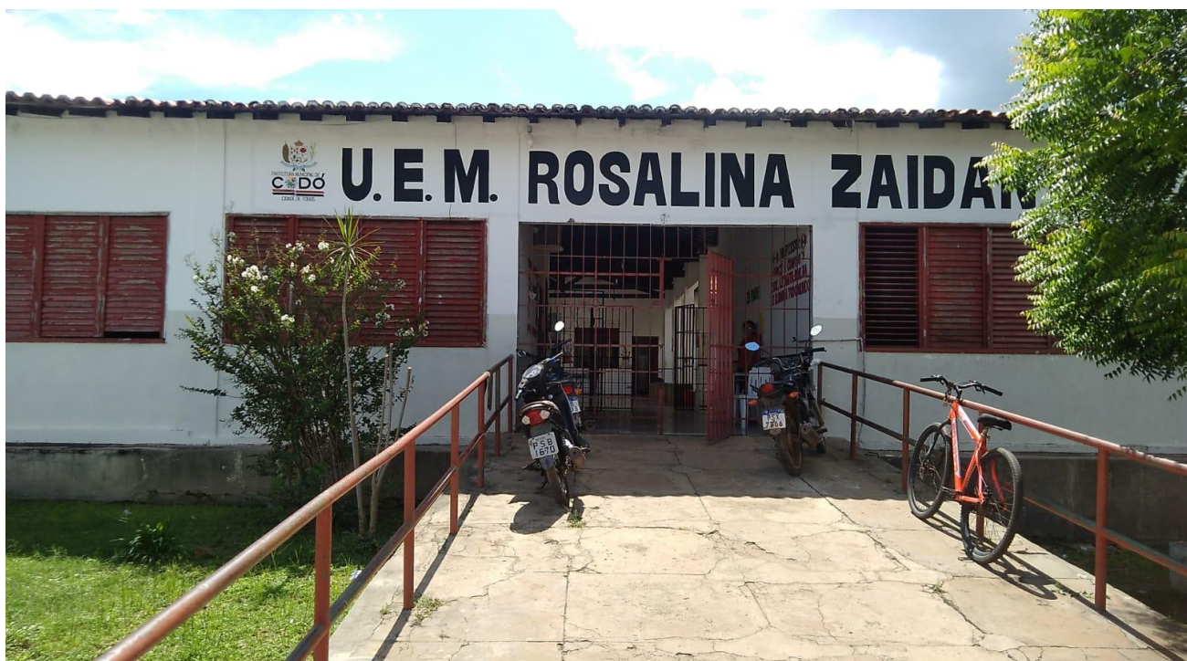
Figura 01: Unidade Escolar Municipal Rosalina Zaidan. Fonte: Mastroine Oliveira, 2024.
