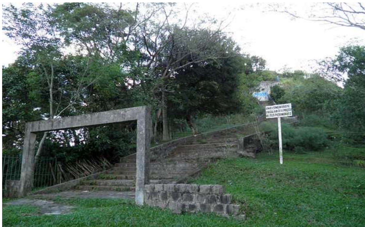
Figura 28 – Monumento Ferroviário (Atual)
