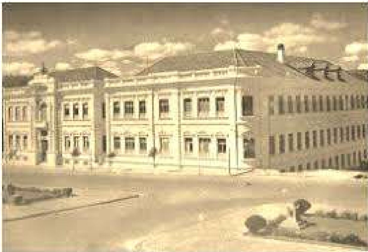
Figura 14 - Escola de Artes e Ofícios, em Santa Maria (ampliada)
