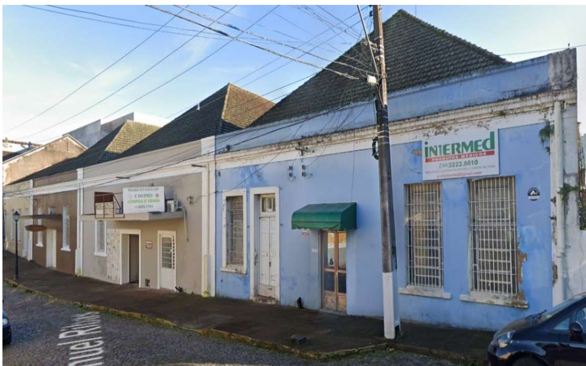
Figura 34 - Armazéns da COOPFER
