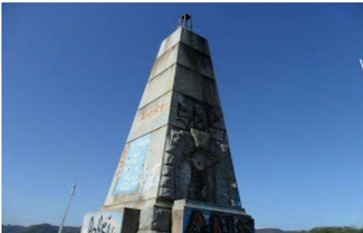
Figura 27 – Monumento Ferroviário (Atual)
