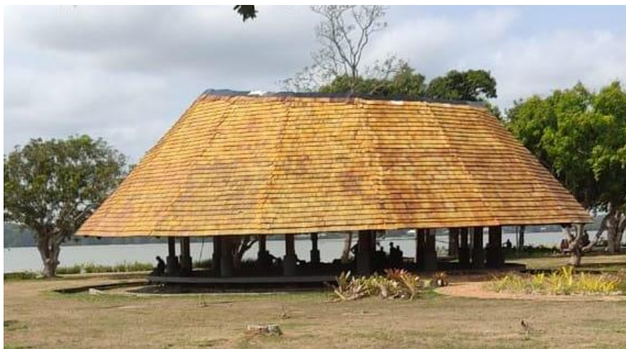
Estrutura no campus UFPA, Belém PA.
