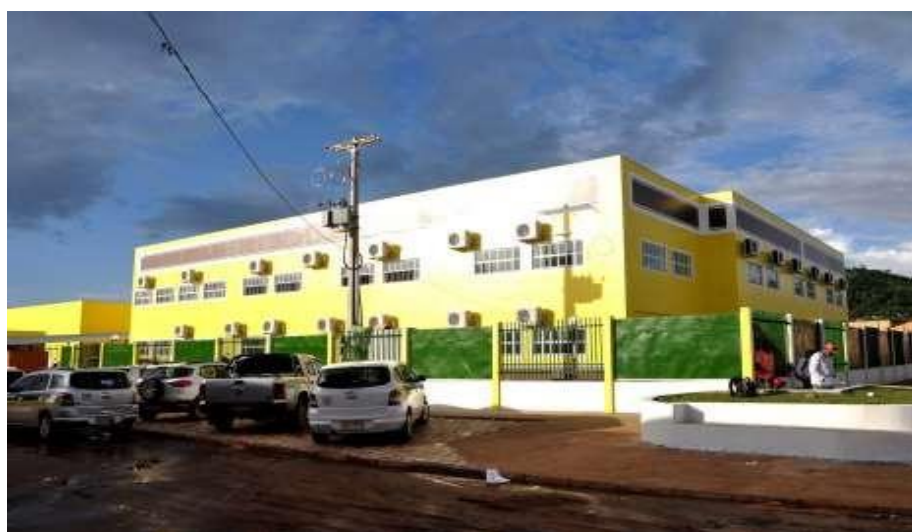
Figura 4 - Fachada da esquina com a avenida Castanheira
