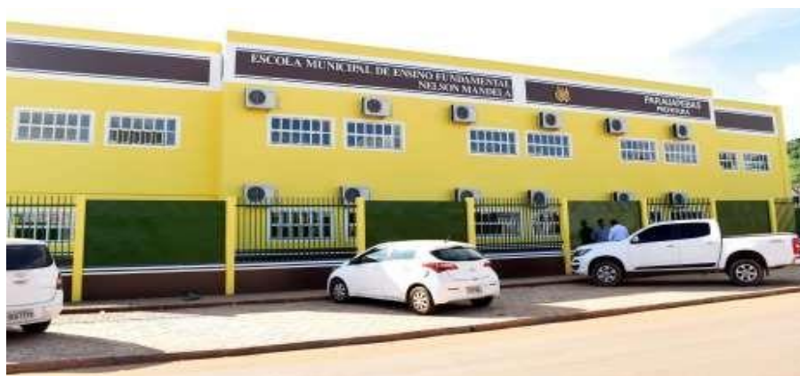
Figura 2 – Fachada central da E. M. E. F. Nelson Mandela.
