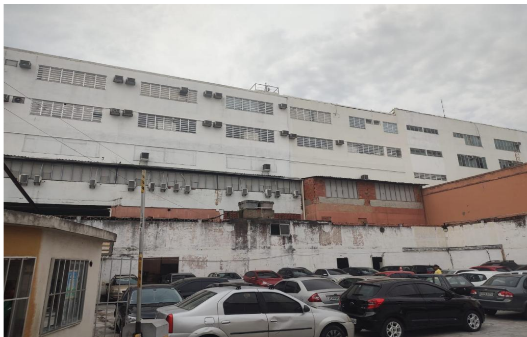
Figura 14 - O prédio da UNIGRANRIO sobre a antiga pedreira de granito preto.
