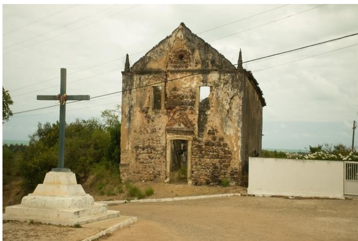
Figura 3 – Ruínas da igreja de São Miguel Arcanjo
