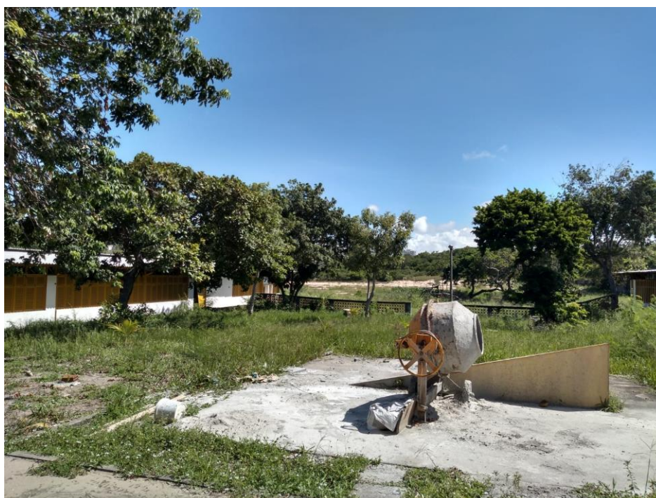
Figura 8 – Zona de Proteção Ambiental (ZPA) ao fundo e máquina de construção civil entre os blocos de aula
