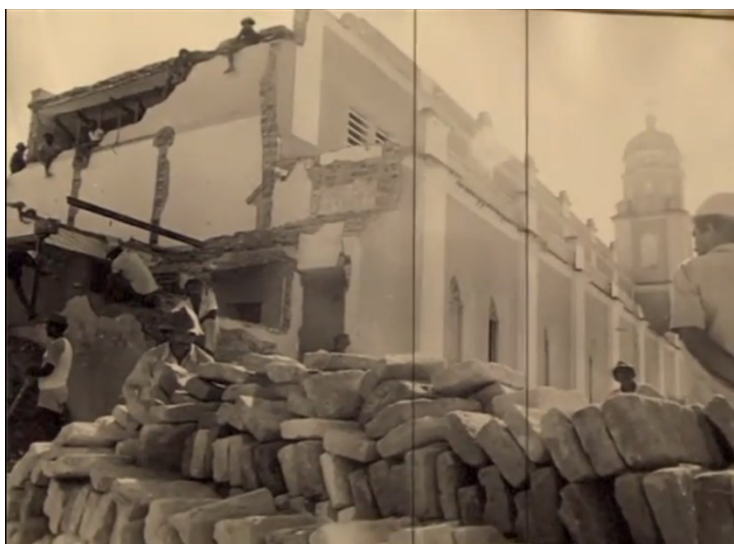
Figura 2 – Danos causados à Igreja Matriz depois do terremoto de 30 de novembro de 1986. Essa imagem está em duas fontes. A primeira delas é a reportagem em alusão aos trinta anos dos abalos em João Câmara pela TV Ponta Negra em 30/11/2016. Disponível em: https://youtu.be/daYakyvuq-c Acesso em 20 set. 2021. A segunda fontes é o acervo de Cosme Souza 32 .
