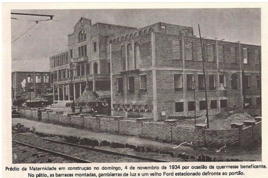
Figura 19: Foto da construção da atual Maternidade Escola Dr. Januário Cicco em 1934. Autoria não informada. Disponível em https://brechando.com/2020/05/26/uma-foto-da-obra-da-maternidade-januario-cicco/ . Acesso em 20 de ago. de 2022.
