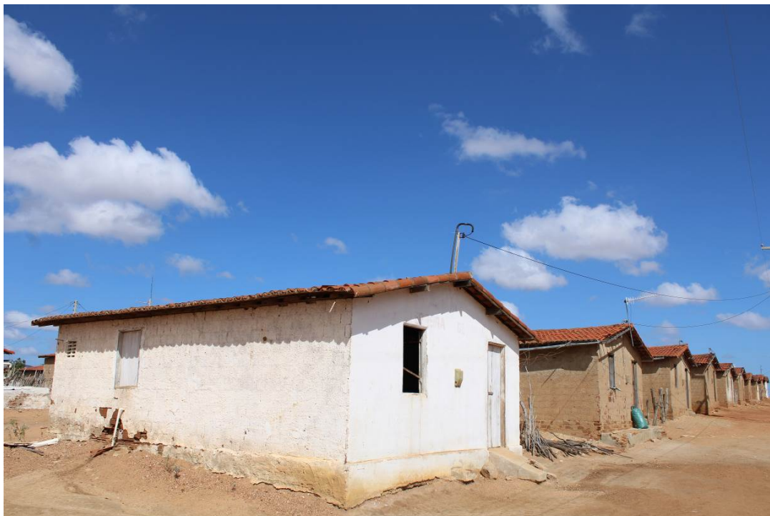
Figura 70 – Vista perfilada da E. M. José Ferreira de Araújo em relação à comunidade casinhas, Vila 2.
