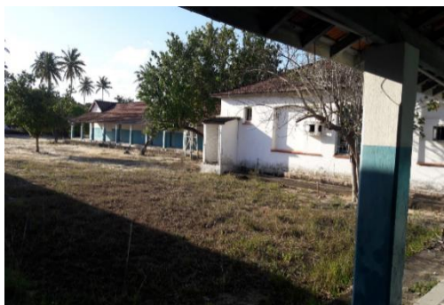
Figura 13 – Estrutura de salas de aula da Escola Estadual Santos Dumont dentro da Base Aérea em 2016
