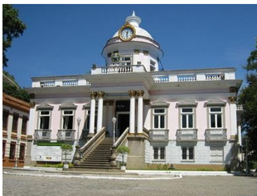
Figura 46 – Prédio onde funciona o Colégio Militar do RJ
