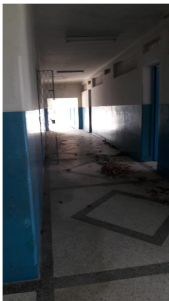
Figura 15 – Estrutura de salas de aula da Escola Estadual Santos Dumont dentro da Base Aérea em 2016
