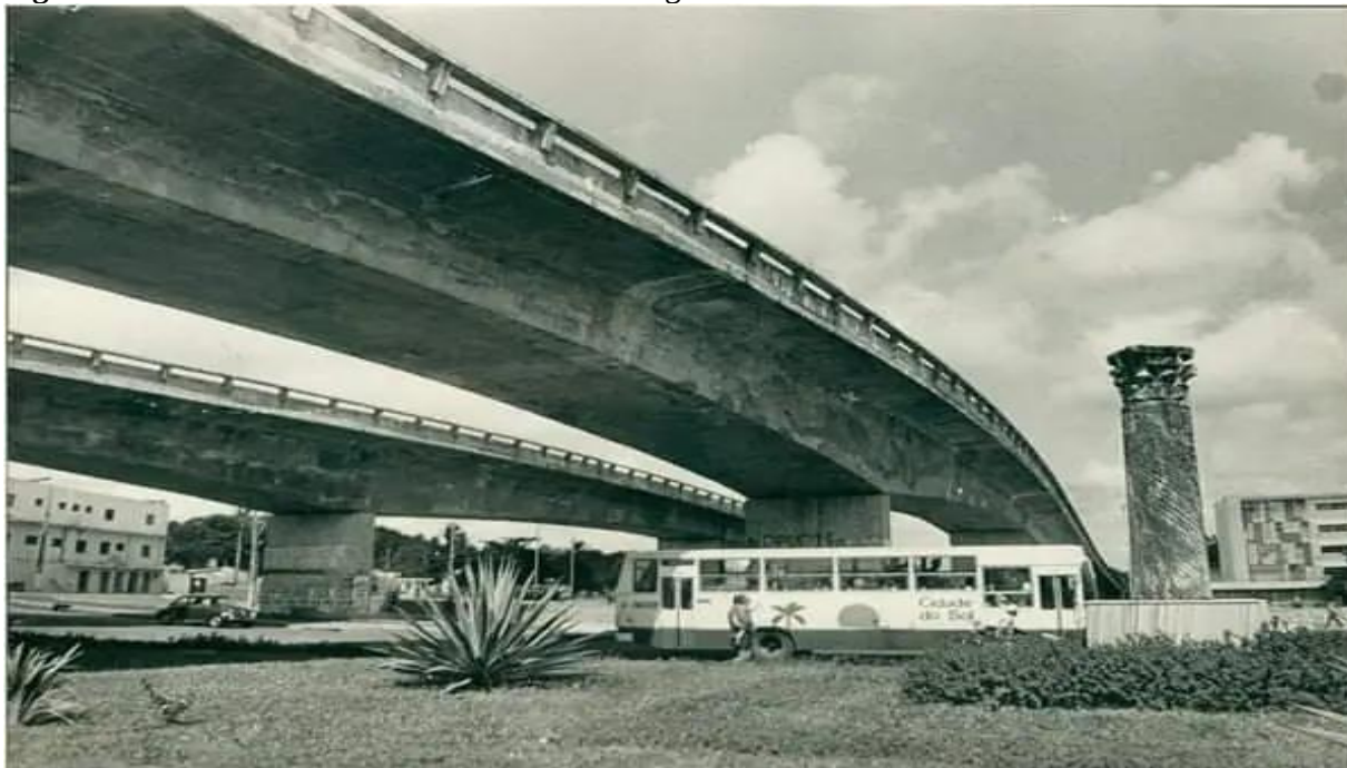
Figura 08 – Foto do Viaduto do Baldo recém inaugurado em 1978
