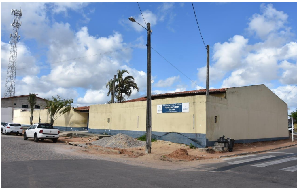
Figura 3: Reforma da Escola Municipal Maria de Lourdes de Lima em 2022.
