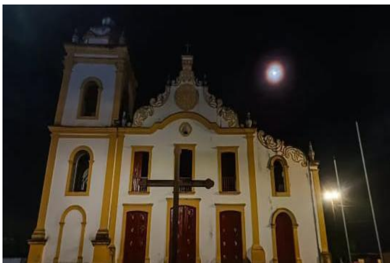
Figura 13: Fachada da Igreja Matriz de São Gonçalo do Amarante
