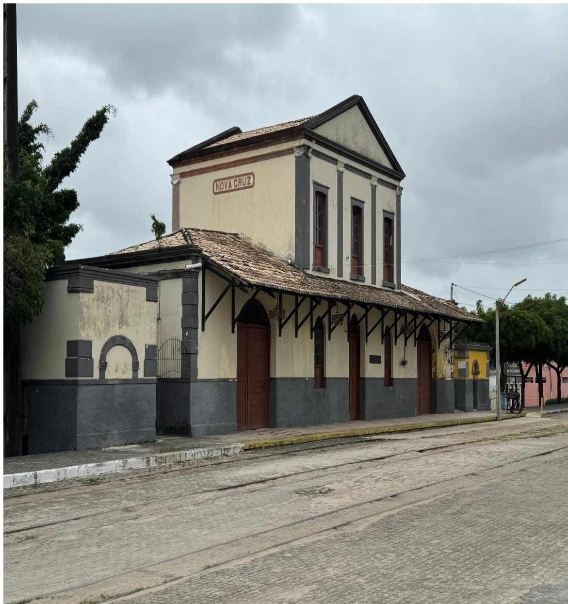
Imagem 9. Foto da casa da cultura (antiga estação ferroviária). Nova Cruz, 2025.
