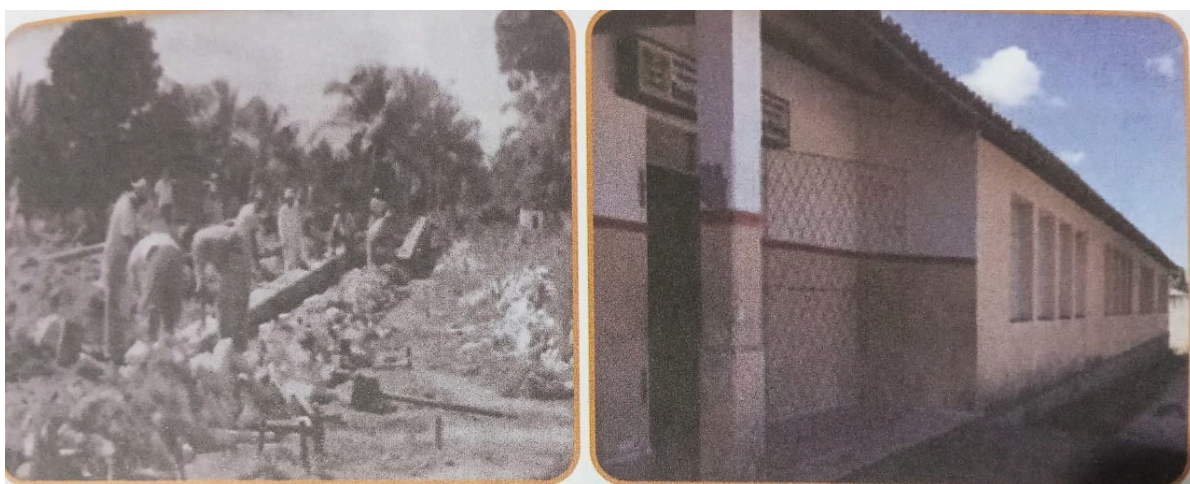
FIGURA 6: Construção da escola João de Paiva
