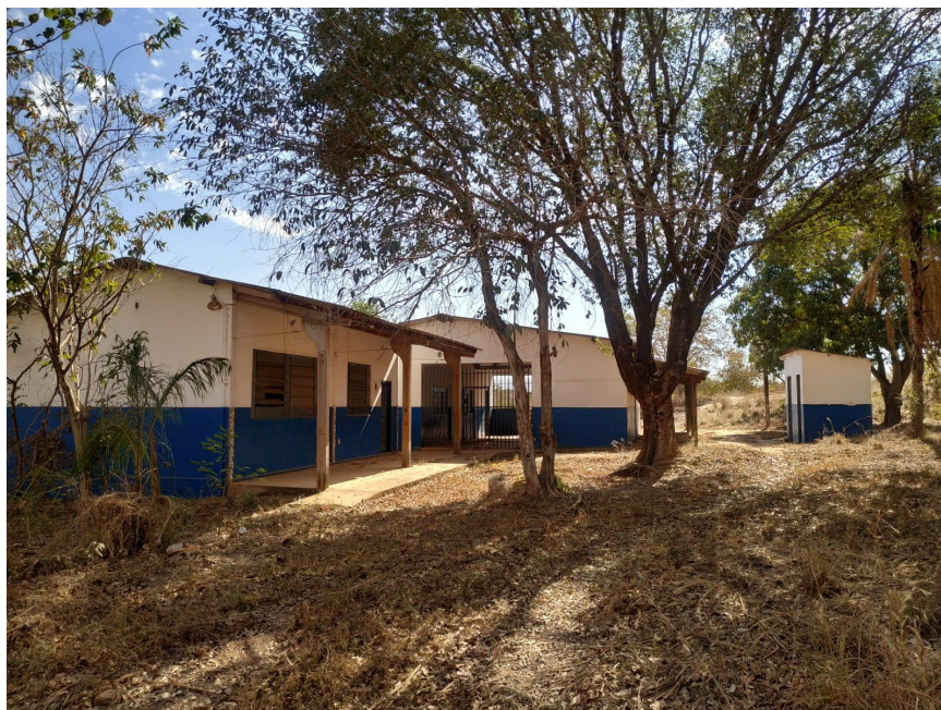
Figura 2 – Vista externa frontal da edificação da antiga EMREB Barreiro Branco, com acesso principal preservado (registro fotográfico, 2025).
