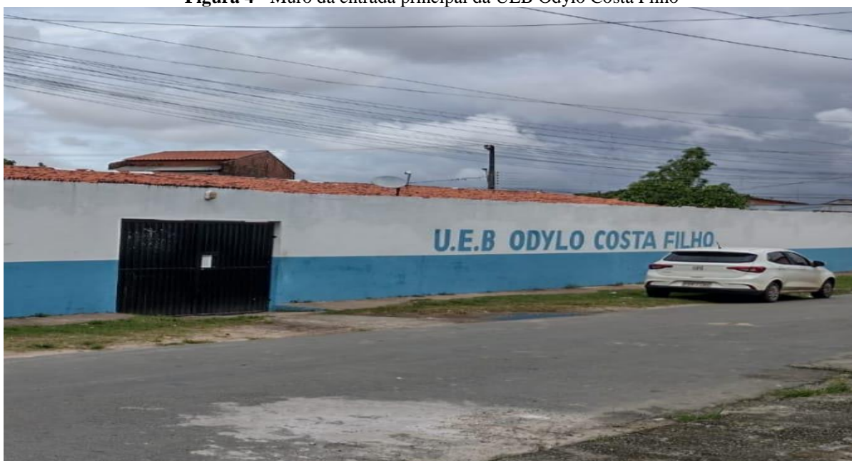
Figura 4 - Muro da entrada principal da UEB Odylo Costa Filho
