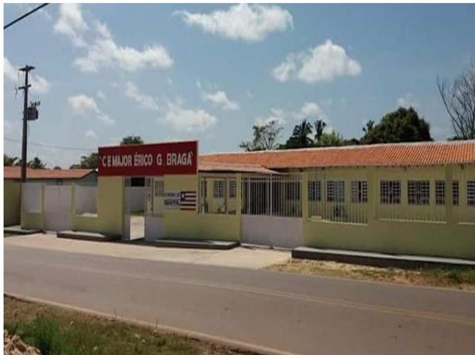
Figura 23 – Entrada da Escola Major Érico Gomes Braga
