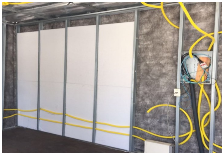
Figura 2 - EPS sendo instalado dentro de um container
