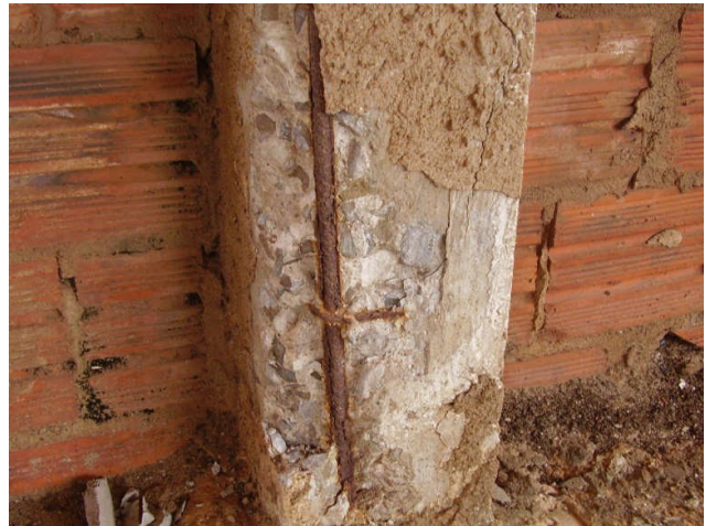
Figura 3. a. Profundidade de carbonatação medida com indicador de pH e b. Pilar com armadura exposta por efeito de corrosão (LIBERATI, 2014).
