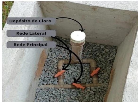
Figura 3 - Clorador de Pastilha, modelo adaptado da Embrapa.
