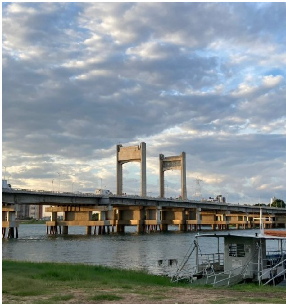
Figura 2 – Vista da ponte sobre o rio São Francisco, ligação entre Juazeiro (BA) e Petrolina (PE), no território da RIDE Petrolina–Juazeiro
