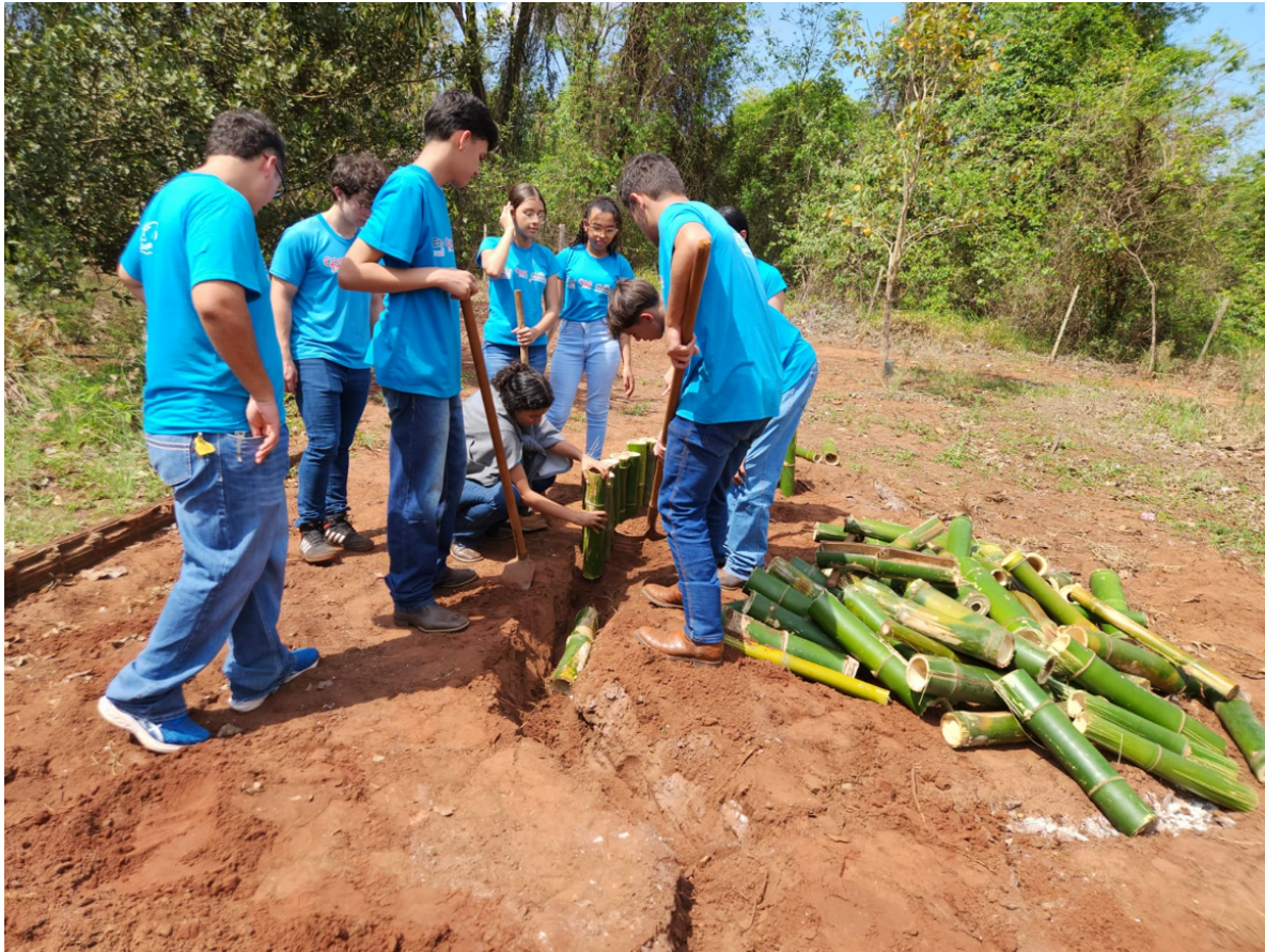
Figura 3. Demarcação da área de horta orgânica com estacas de bambu e cimento.
