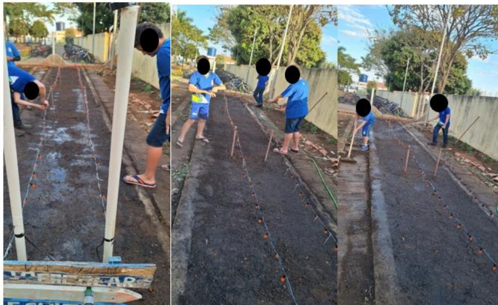
Figura 9: Instalação dos irrigadores na horta
