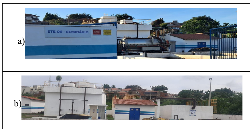
Figura 1 – Entrada (a) e área interna da ETE Seminário, Crato/CE (b)
