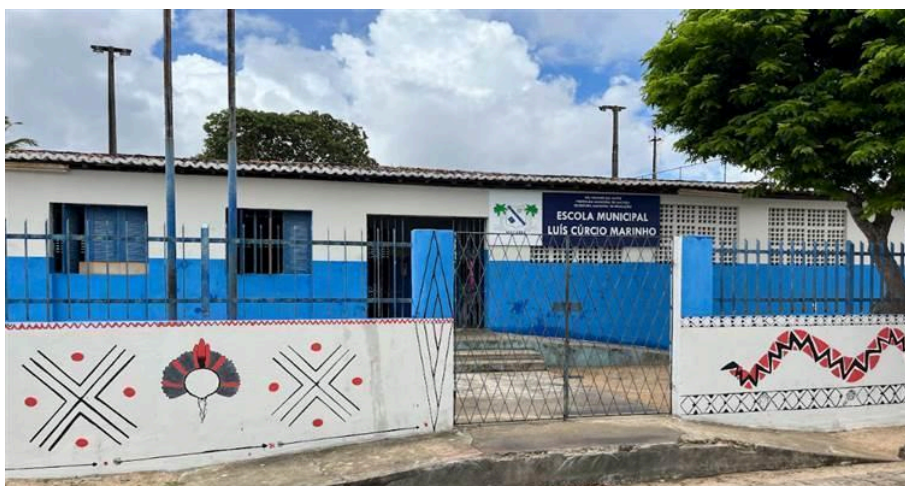
Figura 95 - Fachada da Escola Municipal Luis Crcio Marinho
