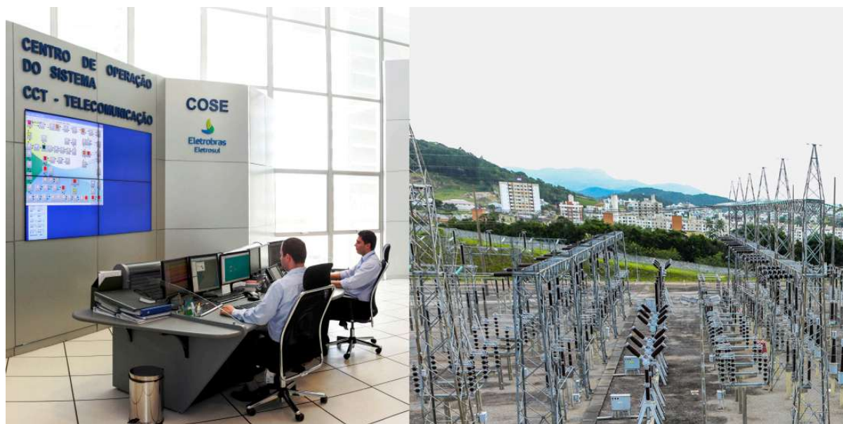
IMAGEM 01 - Sala de Controle (à esquerda) e Pátio de Manobras (à direita)
