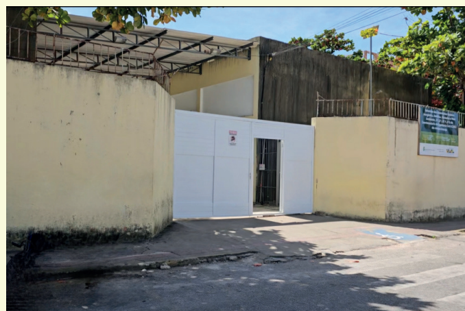
Entrada IFS/Aracaju, acesso pela Rua Estância
