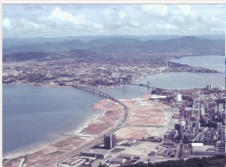
Construção do aterro, década de 70
