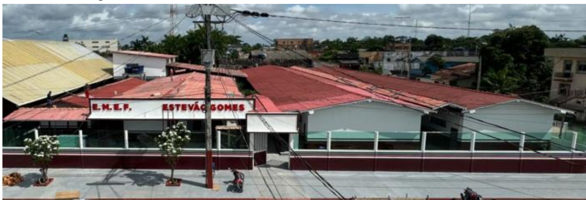
Figura 20 - Fachada da Escola Estevão Gomes, Breves, Pará
