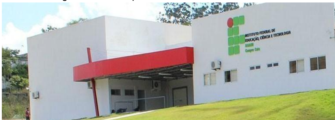
Imagem 1 – Fotografia da fachada Pavilhão 2 do Instituto Federal de Educação, Ciência e Tecnologia Baiano Campus Catu
