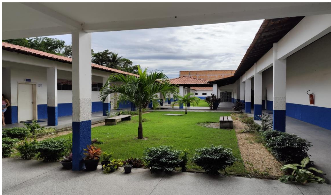
Imagem 3- Blocos de Sala à direita do Corredor de Entrada
