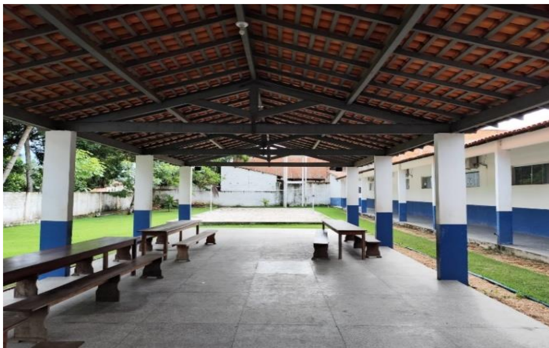
Imagem 4 – Refeitório e Quadra de areia o fundo.
