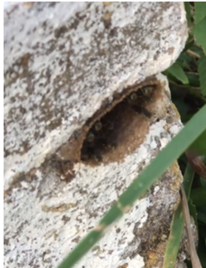
Figura 25: Iraí na caixa de energia
