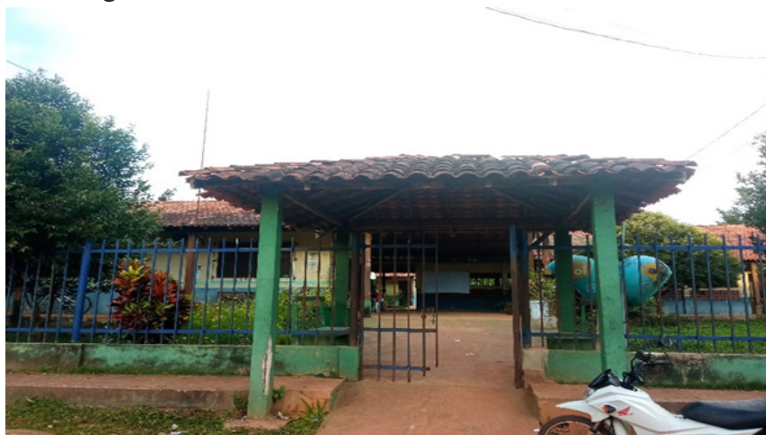
Figura 1: Escola E.M.E.I.F. Nossa Senhora do Carmo
