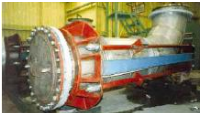
Figura 2.23 - Junta de Expansão Universal Balanceada.
