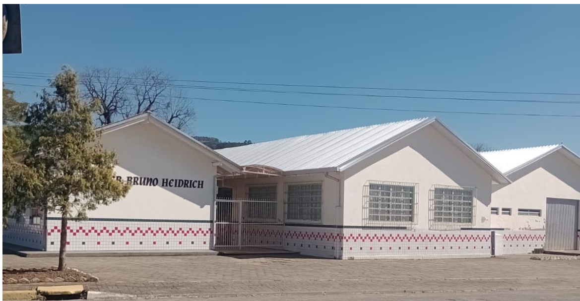
Figura 1: Vista da entrada da EEB Bruno Heidrich, 2025.
