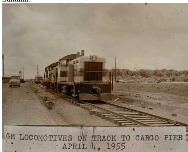
Foto 033 – Locomotivas modelo SW – 1200, fabricante General Motors – USA. Abril de 1955 – pátio de Santana.
