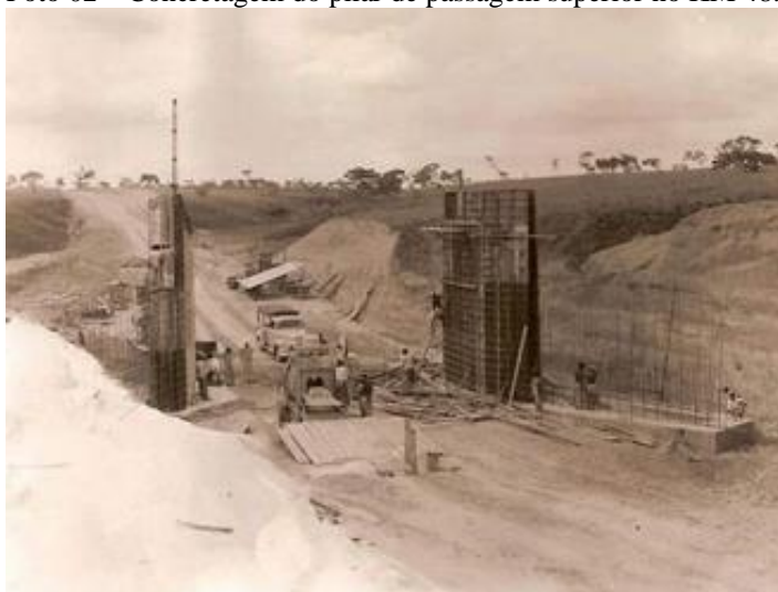
Foto 02 – Concretagem do pilar de passagem superior no KM 48. Ano de 1955.
