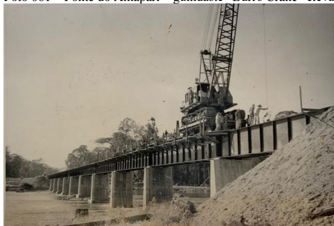
Foto 061 – Ponte do Amapari – guindaste “Burro Crane” elevando vigas de aço. 20 de setembro de 1955.
