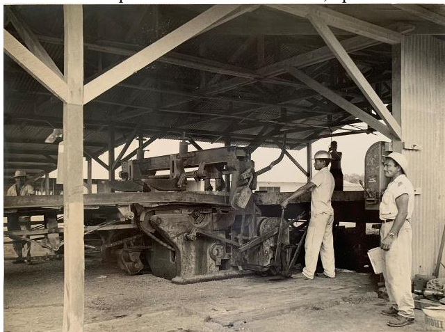
Foto 042 – Máquina de entalhar dormentes, operador “Arara”, área industrial de Santana. Setembro de 1956.
