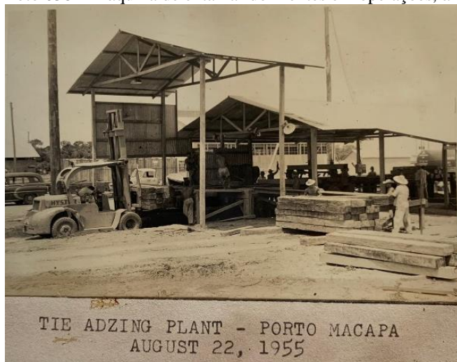
Foto 038 – Máquina de entalhar dormentes em operações, área industrial de Santana. 22 de agosto de 1955.
