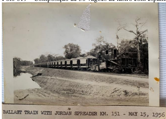
Foto 019 – Composição de 30 vagões de lastro com espalhadeira, Km 151. 10 de maio de 1956.
