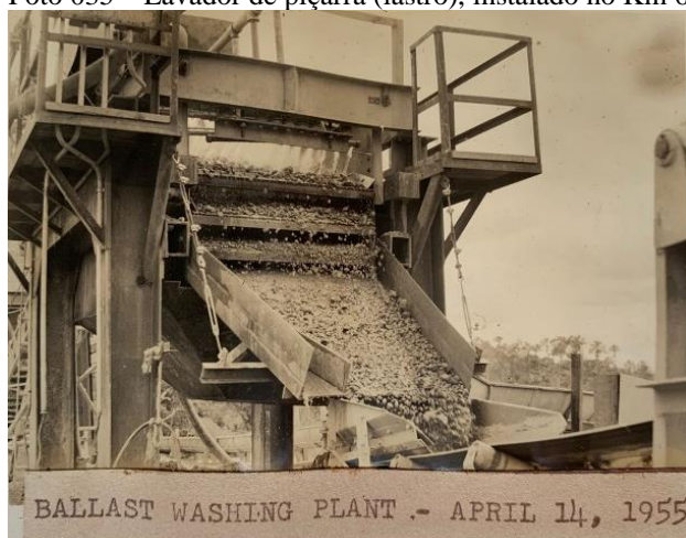
Foto 035 – Lavador de piçarra (lastro), instalado no Km 62. 14 de abril de 1955.
