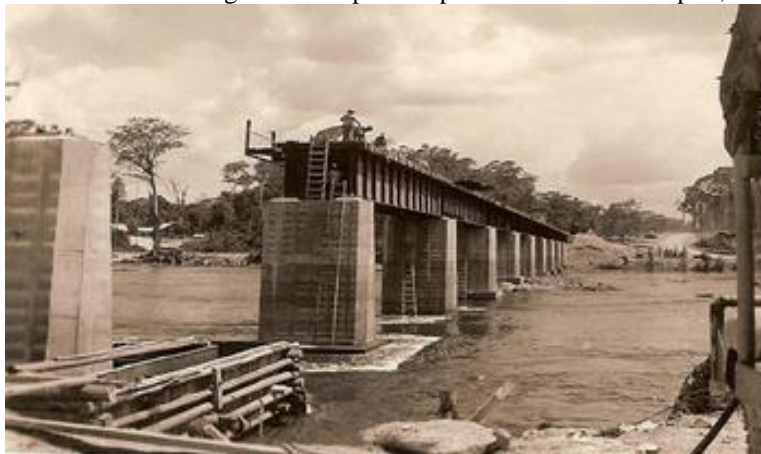
Foto 010 – Concretagem do 10º pilar da ponte sobre o rio Amapari, em Pedra Branca. Ano de 1956.
