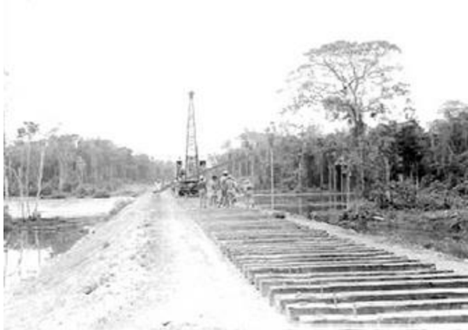
Foto 01 – Início da construção da Estrada de Ferro do Amapá – EFA. Montagem dos trilhos sobre os dormentes, alinhados e nivelados sobre o lastro. Anos 50.
