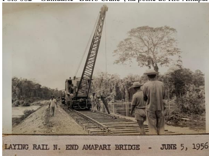
Foto 062 – Guindaste “Burro Crane”, na ponte do Rio Amapari, Km 178. 05 de junho de 1956.
