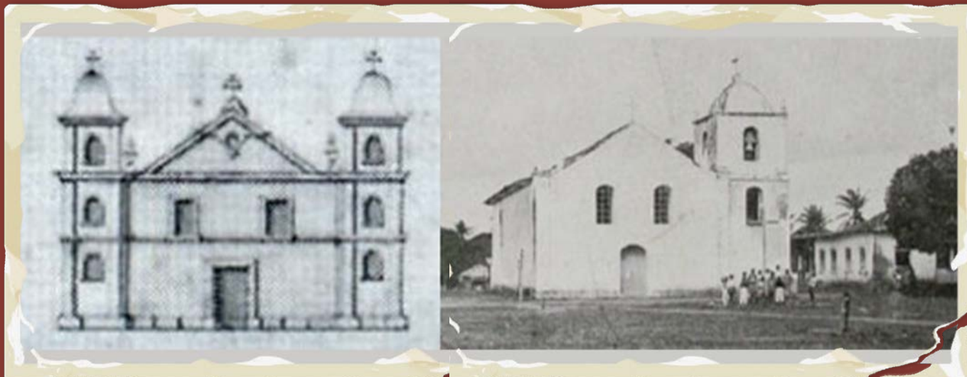
Imagem 60: Comparação entre a fachada frontal projetada (1758) e a executada (1930)
