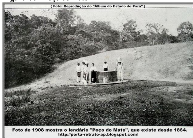
Figura 06 - Poço do mato
