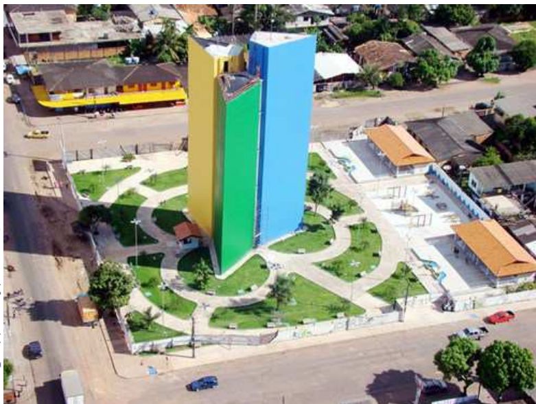
Fotografia aérea da Praça da caixa d'água às vésperas de sua reinauguração em 2009.
