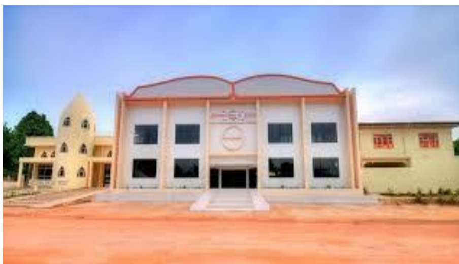
Novo templo da Assembleia de Deus na Rua Emílio Médici, Bairro do Agreste 2015. Fonte: adlj.com.br
