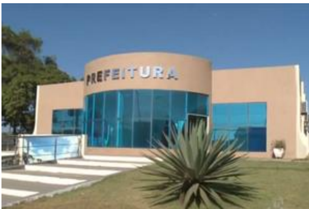
O antigo Fórum de Laranjal do Jari, em 2012, deu lugar ao atual prédio da Prefeitura. O Fórum passou a funcionar no prédio ao lado da Prefeitura. Fonte: g1.globo.com
