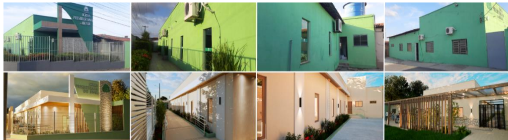
Figura 6 – Fachadas (frontal, laterais esquerda e direita, e posterior) atualmente e renderização após o retrofit
