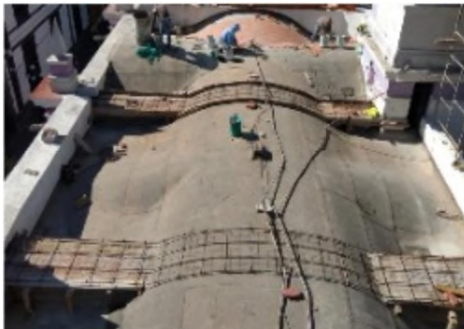
Figura 8. Tensores sobre losa, para refuerzo estructural de contrafuertes. Fotografía: EDCA.
