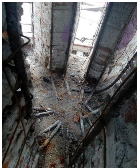
Figura 5. Acero de refuerzo al interior de las pilastras que sostienen a la linternilla. Fotografía: JECL.
