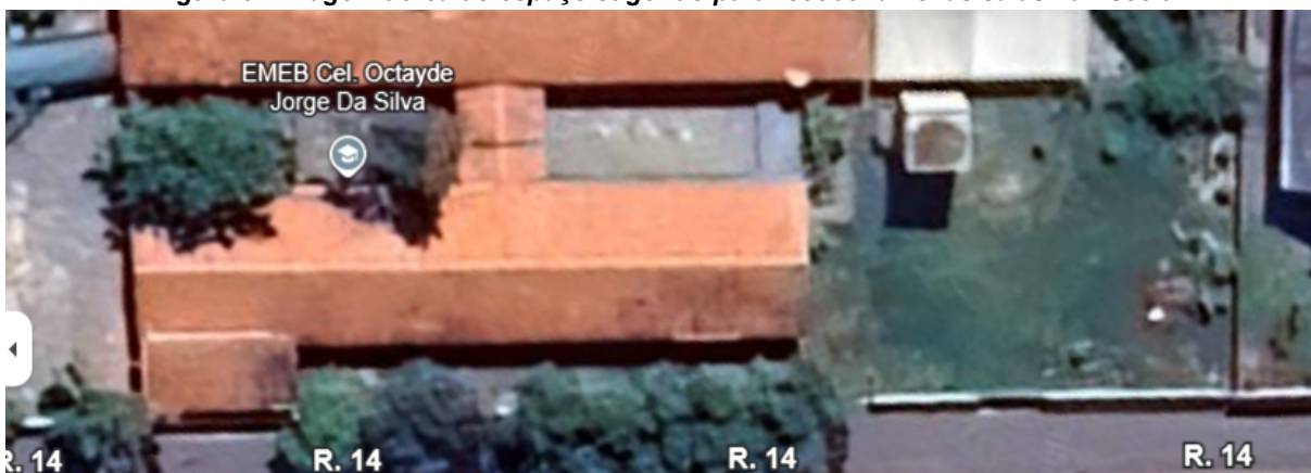
Figura 3 - Imagem aérea do espaço sugerido para receber a novas salas na Escola
