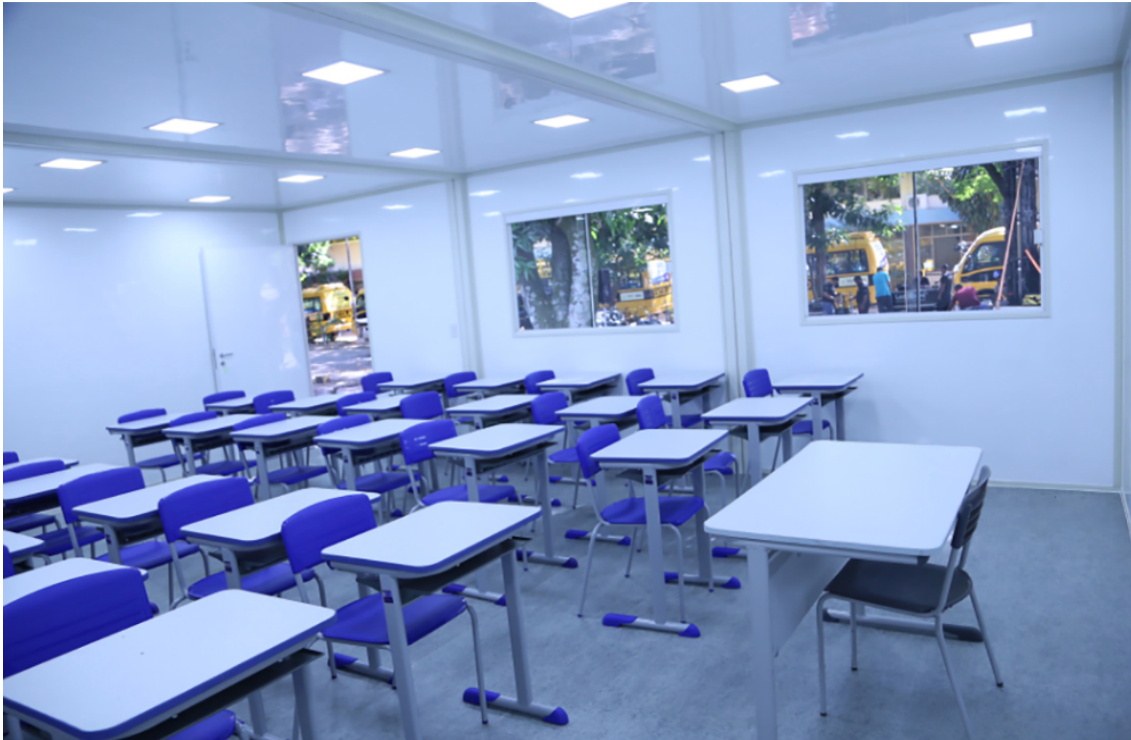
Figura 12 — Ambiente interno de uma sala de aula em painel isotérmico com forro
