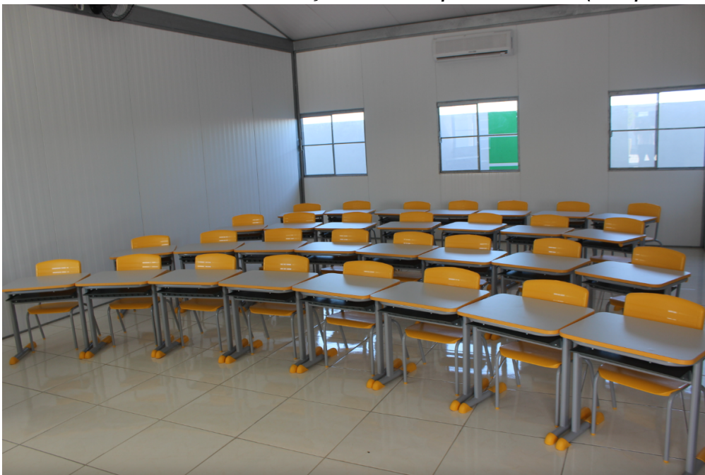
Figura 11 — Sala de aula interna em construção modular de painel isotérmico (exemplo em Cuiabá)
