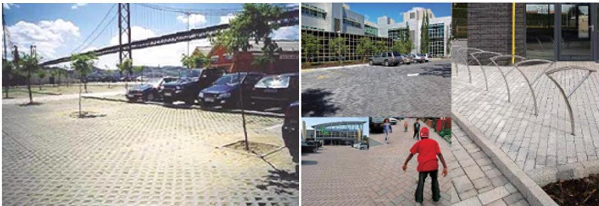
Figura 2: Pavimentos intervalados por gramíneas e Pavimentos intervalados.
