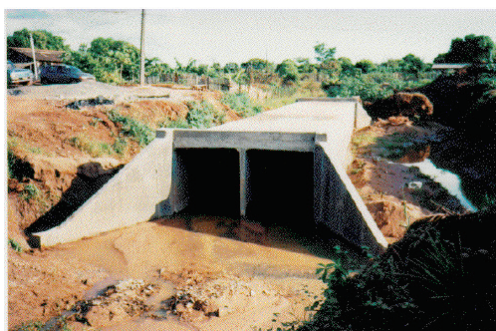
Figura 39 – Água acumulada em uma sarjeta (microdrenagem) e um bueiro celular duplo (macrodrenagem)
