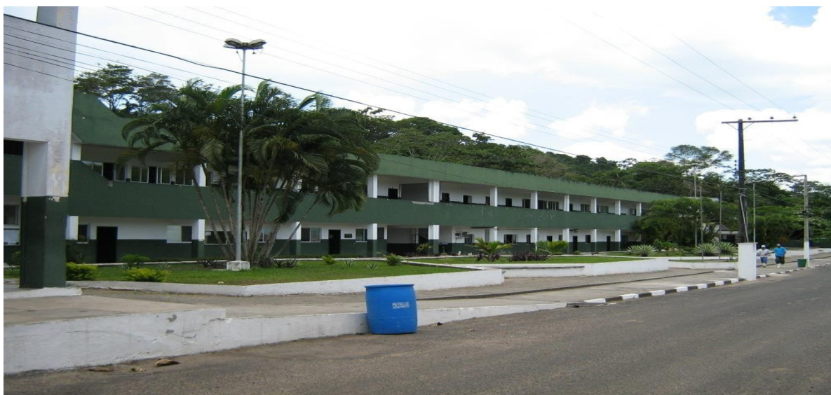
Imagem 02 – Foto parcial do Pavilhão antigo (1) antes da reforma
