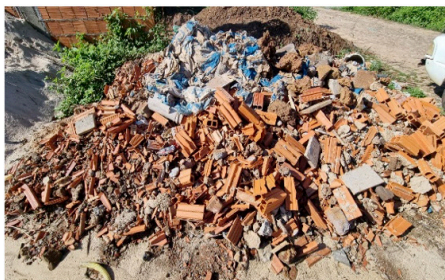
Figuras 02 e 03 – Obra 1: Sem segregação de RCDs e reutilização de corte para aterro
