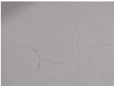
Figura 1 – Fissura por retração do revestimento localizada na área de circulação (residência B)
