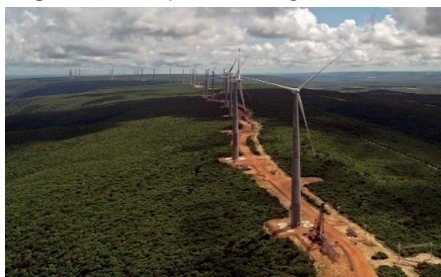
Figura 04 - Parque eólico Lagoa dos Ventos
