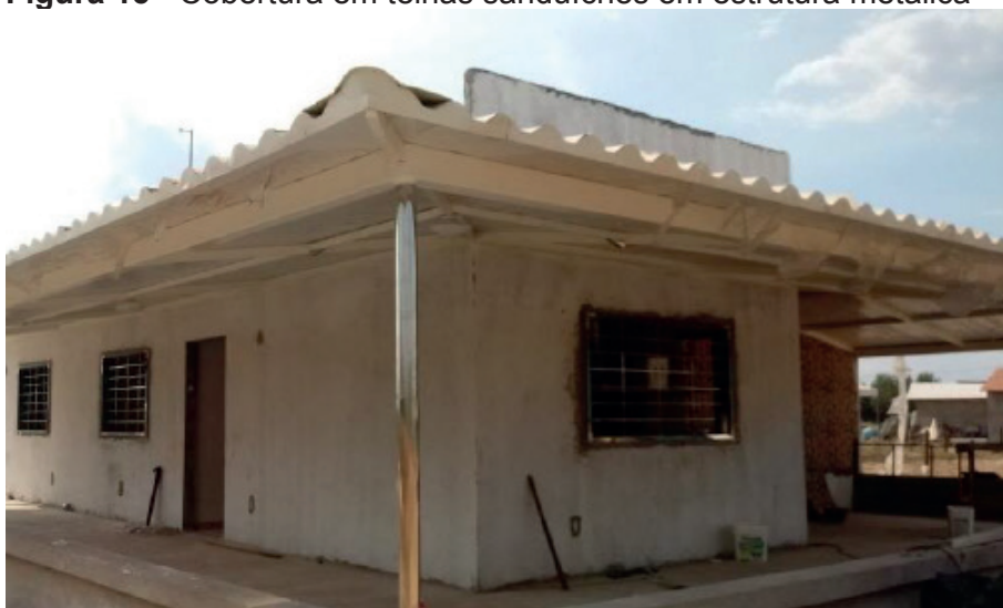
Figura 15 - Cobertura em telhas sanduíches em estrutura metálica
