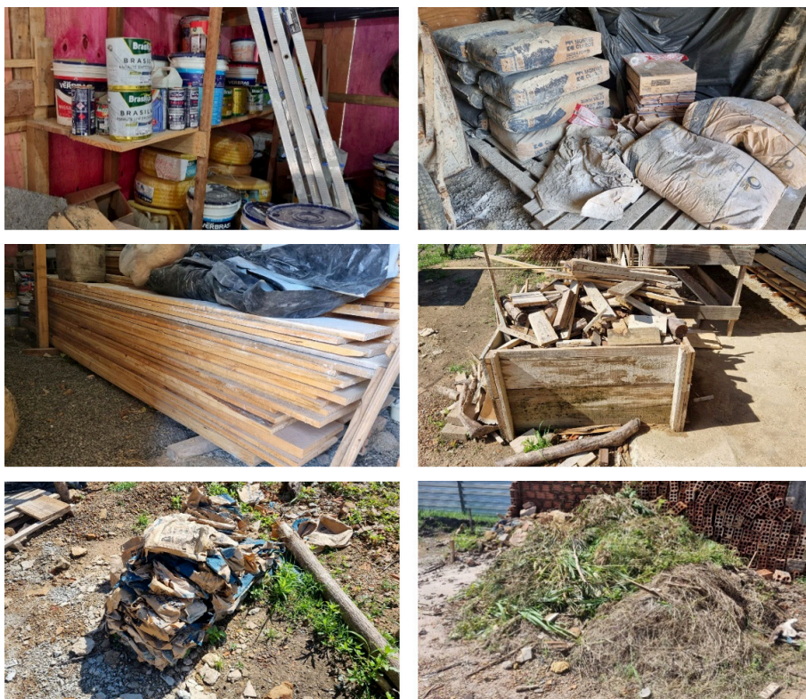
Figuras 06, 07, 08, 09, 10 e 11 – Obra 3: Algumas BPG observadas como segregação dos RCDs e armazenamento adequado de alguns materiais
