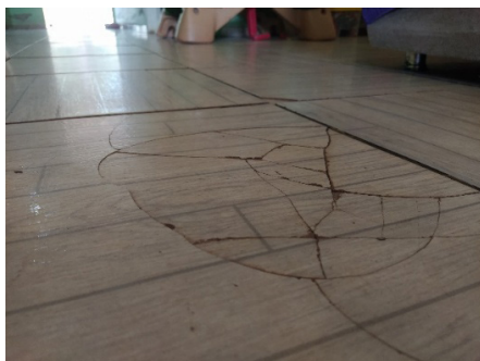
Figura 11 – Descolamento de revestimento cerâmico na sala (residência A)
