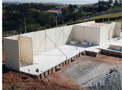
Figura 06 - Fundação em sapatas corridas
