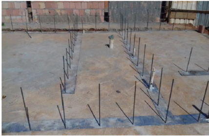
Figura 07 - Fixação dos arranques
