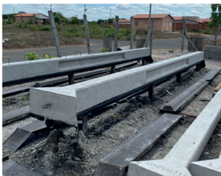
Figuras 10, 11, 12 e 13 – Produção das peças pré-moldadas
