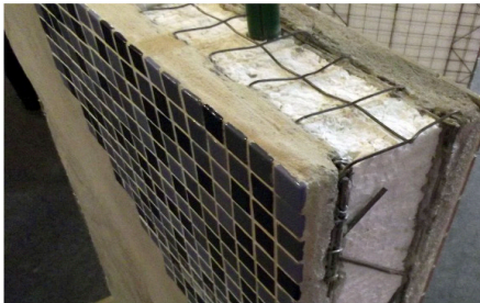
Figura 03 - Painéis monolíticos de EPS Figura 04 - Painéis monolíticos de EPS
