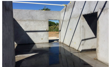
Figura 14 - Revestimento dos painéis e revestimento do piso
