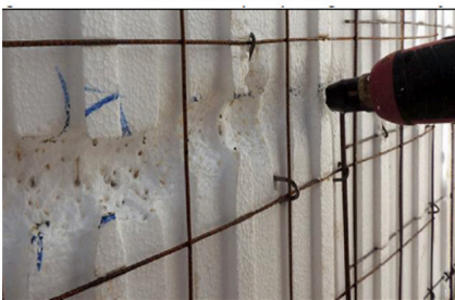
Figura 09 - Abertura para passagem de tubulações
