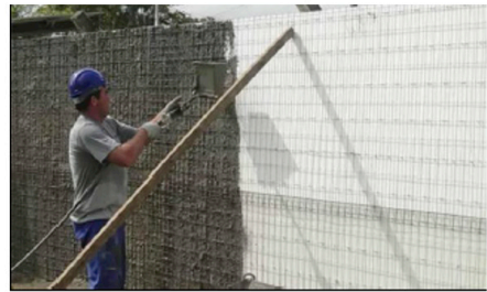
Figura 12 - Primeira camada de revestimento dos painéis
