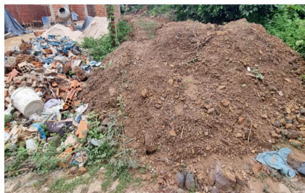
Figuras 02 e 03 – Obra 1: Sem segregação de RCDs e reutilização de corte para aterro
