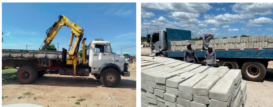
Figura 21 e 22 – Veículo de Içamento e Montagem
