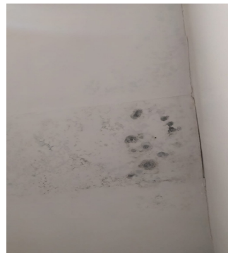
Figura 14 – Mofo no gesso no quarto 02 (residência B)
