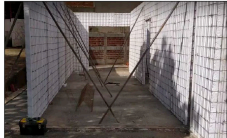
Figura 08 - Escoramento dos painéis
