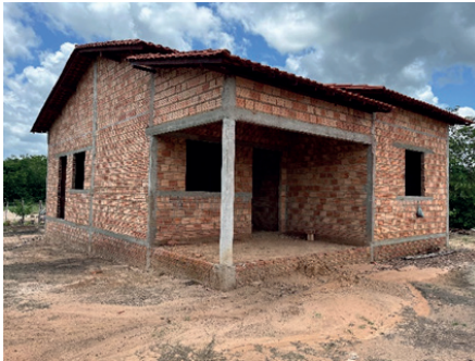
Figuras 04 e 05 - Visões das Edificações em suas Fases
