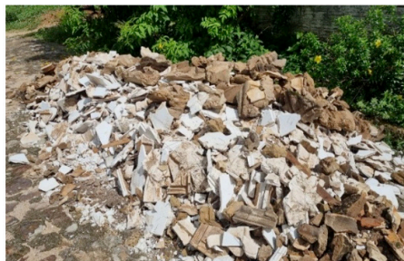
Figuras 04 e 05 – Obra 2: Relativa segregação dos tipos de RCDs
