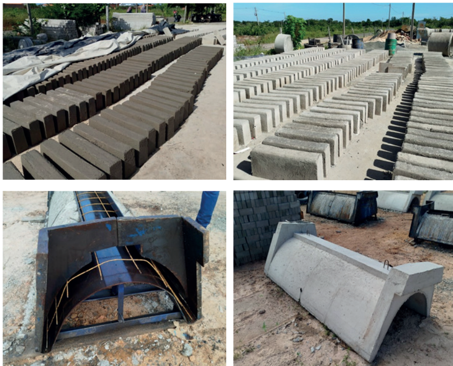
Figuras 02, 03, 04 e 05 – Produção das peças pré-moldadas
