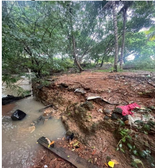
Figura 20: Leito do Igarapé Traíra
