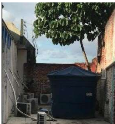
Imagem 18. Sistema de captação de água pluvial do CEHMA – reservatório 1.
